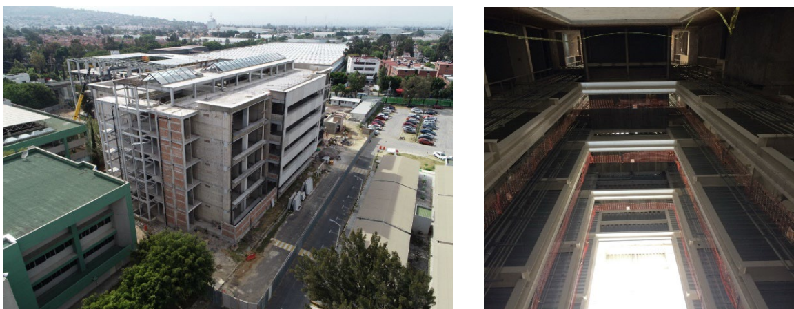
Figura 3. Estado actual del módulo B del edificio de Ciencia y Tecnología
