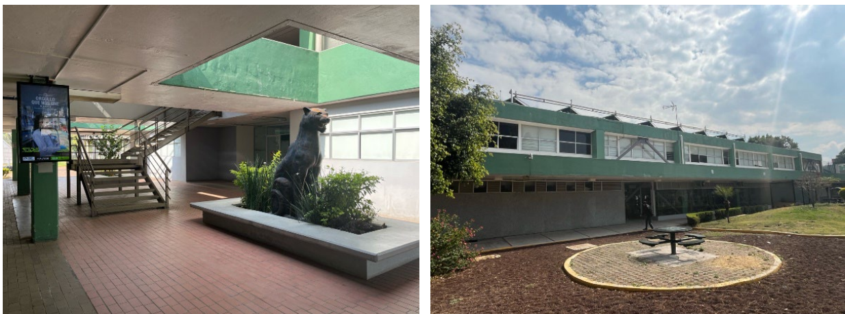
Figura 5. Costado norte del edificio M (COSIB y Unigénero)
