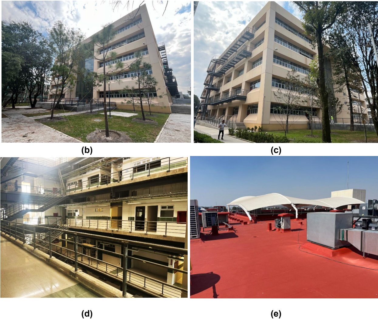
Figura 1. Estado del edificio S (a) en enero de 2022 (b), (c), (d) y (e) en enero de 2026
